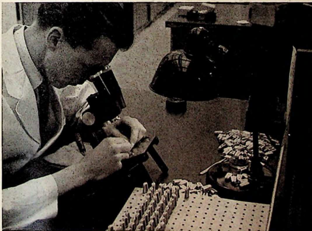
Piëzo-electrische elementen worden nauwkeurig onderzocht, de saffier krijgt speciaal aandacht
